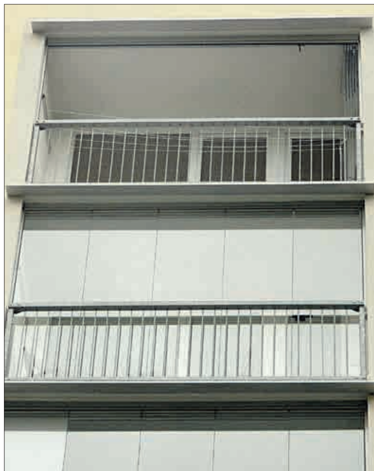
Teplice, sídliště Nová Ves, Javorová ulice. Zde bylo namontováno „celosklo“ včetně plisé. Horní balkon je zcela otevřen, na spodním balkonu je vidět pět skleněných částí.
