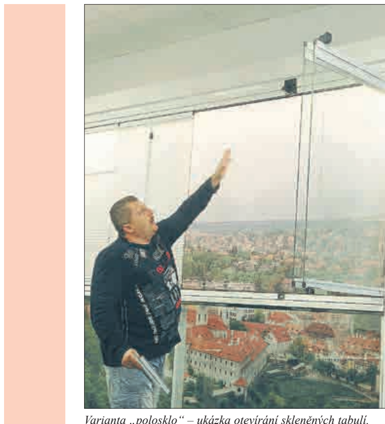
Varianta „polosklo“ – ukázka otevírání skleněných tabulí.
