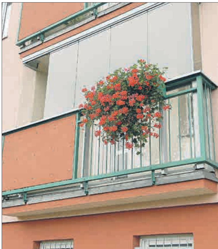
Teplice, Duchcovská ulice, dům SBD Mír. Zde byla namontována varianta „polosklo“, sestávající z pěti částí (část zcela vlevo je právě otevřená). Systému Lumon nevaří ani truhlík s květinami. Na zábradlí je vodící hliníkový profil.
